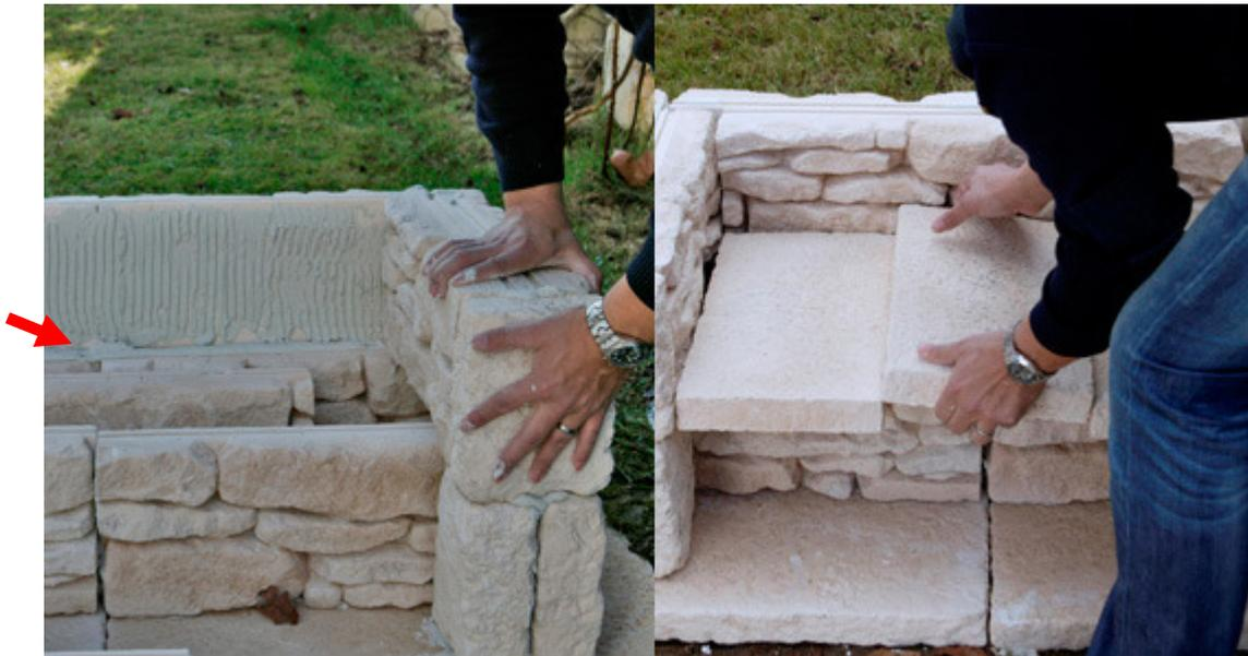
Prima di posare il Copri Muro Bridoire, incollare un elemento Idealblok Piano internamente alla struttura del Barbecue, a ridosso della parete più lunga. Tale elemento fungerà d'appoggio per il Copri Muro Bridoire.
