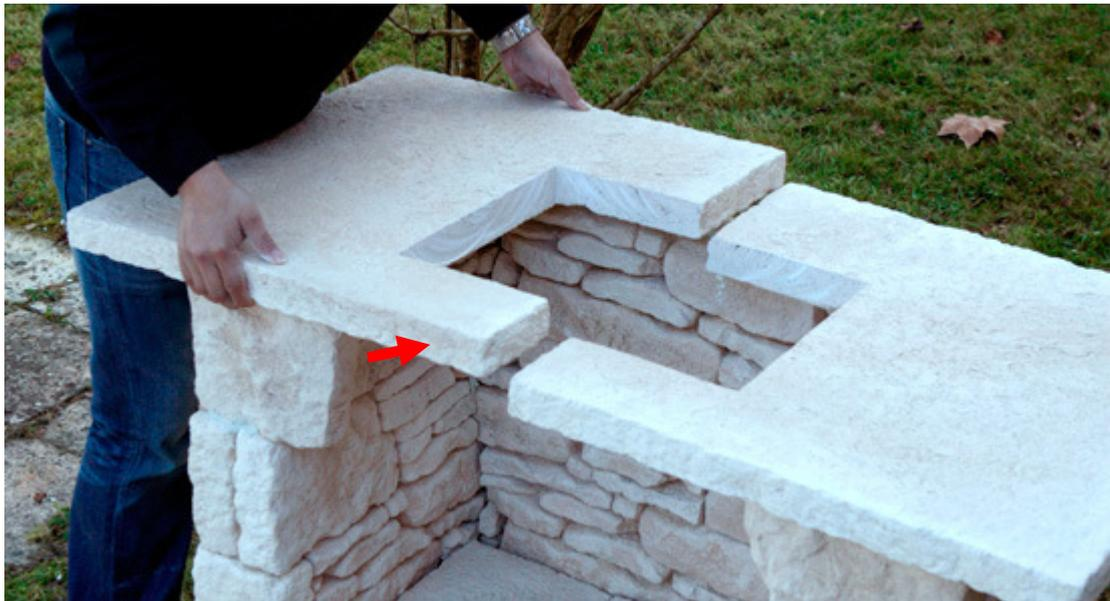
Posare le due lastre di Copri Muro Pietra dell'Altopiano al suolo e segnare le dimensioni della griglia (dimensioni max L.60 x l. 35).
