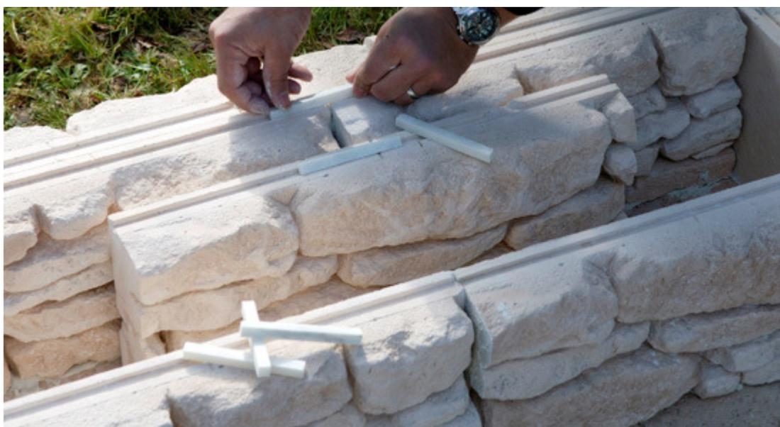
A cavallo tra i vari moduli Idealblok della prima e della seconda fila, inserire le barrette nella loro apposita sede. Permetteranno di posare in asse i moduli d'una fila sull'altra.
